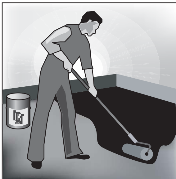
Рис. 15. Нанесение праймера.
